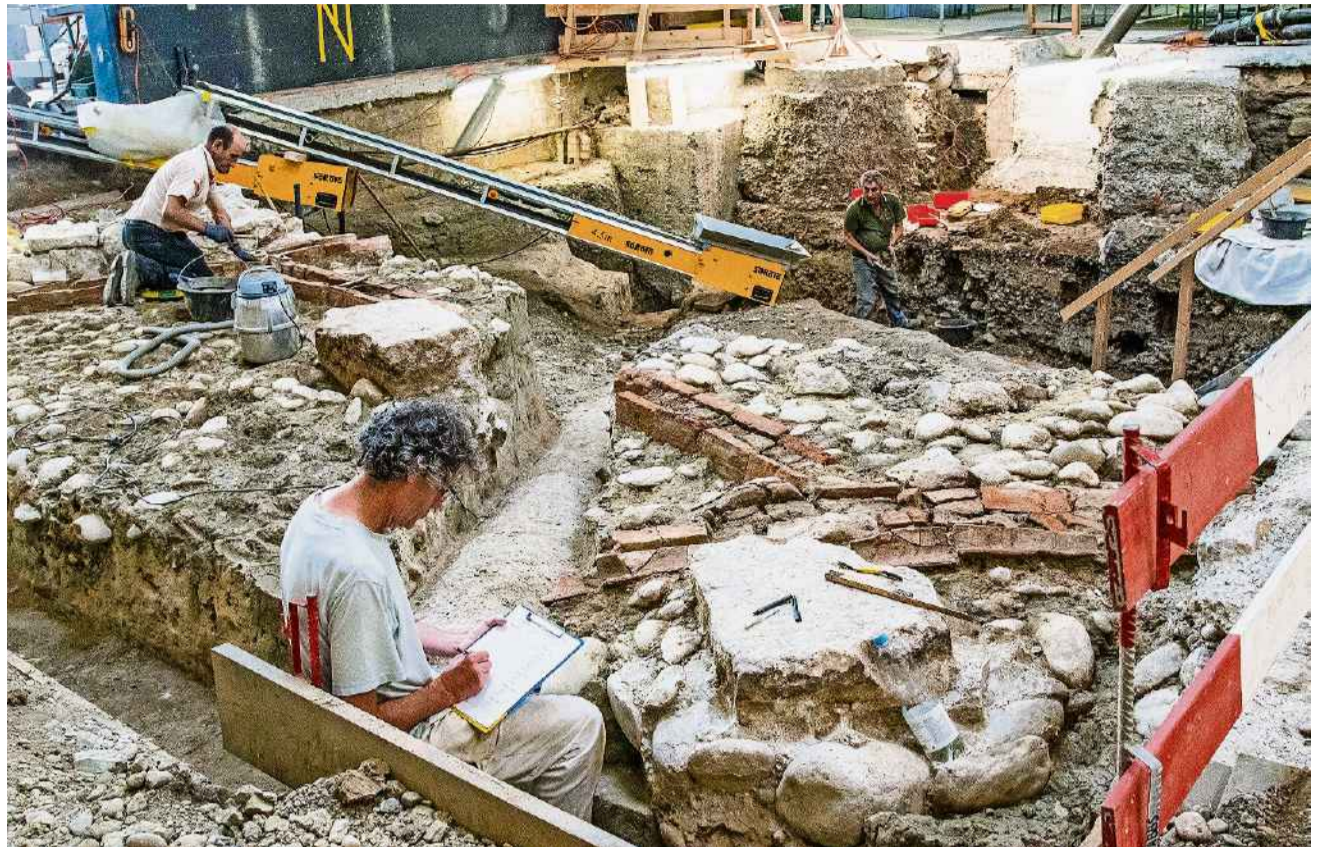
Mauer und Kanal werden ausgegraben, gut zu sehen ist der für die Arbeit wichtige Staubsauger.
